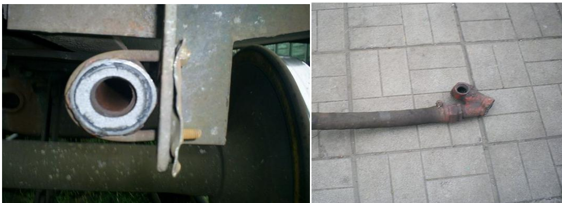
Рисунок А.17 – Злам штуцера кінцевого крану через наявність тріщини старого походження та недостатнє кріплення магістрального повітропроводу
