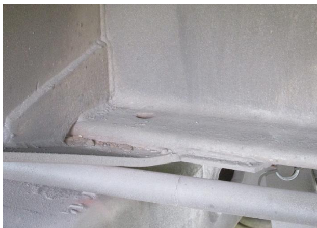
Рисунок А.27 – Відсутність заклепки кріплення п'ятника до рами вагона
