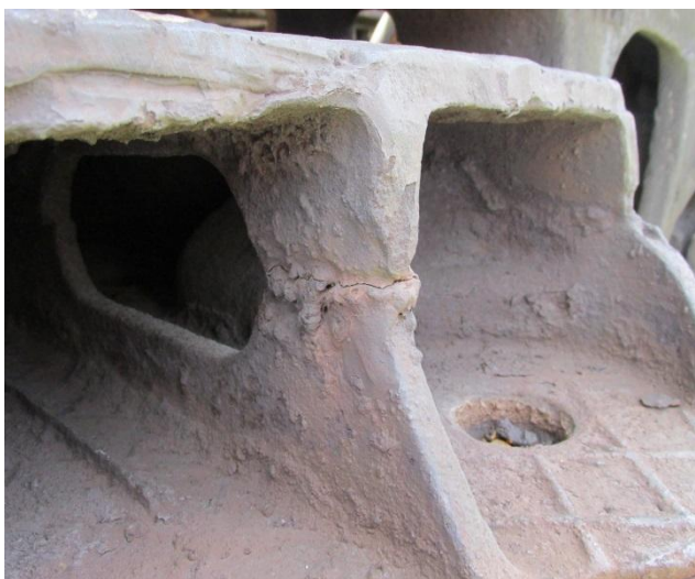
Рисунок А.31 – Тріщина надресорної балки
